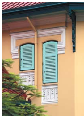
ปูนปั้นบริเวณเชิงผนังใต้หลังคา คิ้วบัวปูนปั้นรูปโค้งลายพันปลาเหนือกรอบหน้าต่างชั้นบน
