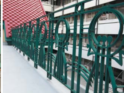
ราวระเบียงเหล็กดัดบริเวณดาดฟ้า
