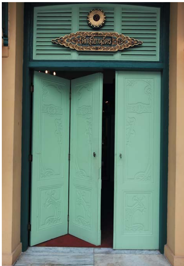
เหนือประตูทางเข้าอาคารมีช่องลม ตีเกล็ดไม้ ประดับด้วยเครื่องหมาย ของพระยาสุรียานุวัตร
