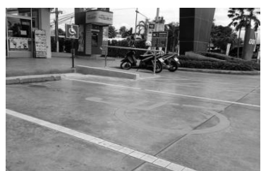
ที่จอดรถ และทางลาดในปั๊มน้ำมัน ปตท.
