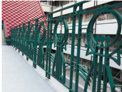
ราวระเบียงเหล็กตัดบริเวณดาดฟ้า
