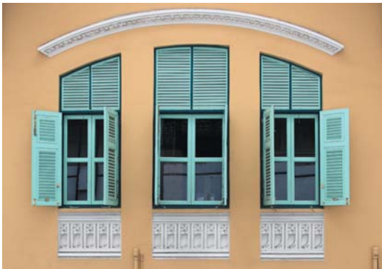
ปูนปั้นบริเวณเชิงผนังใต้หลังคา คิ้วบัวปูนปั้นรูปโค้งลายพันปลาเหนือกรอบหน้าต่างชั้นบน
