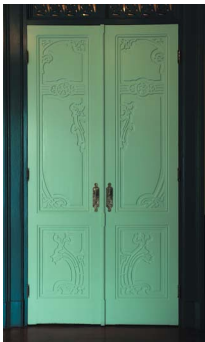
ประตูไม้ลูกฟักดุนเปิดปิดแบบบานคู่ หน้าบานประตู แกะสลักลายพันธุ์พฤกษายภายในกรอบลูกฟัก
