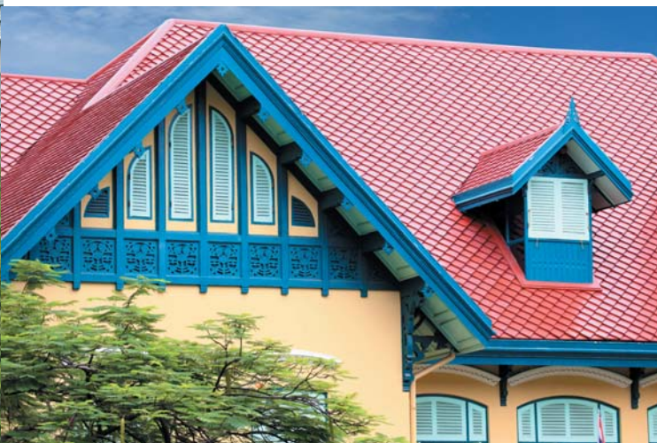
หน้าต่างบานเกร็ดที่ห้องใต้หลังคามีแนวเส้นคั่นเป็นระยะ ตรงกับแปหลังคา
