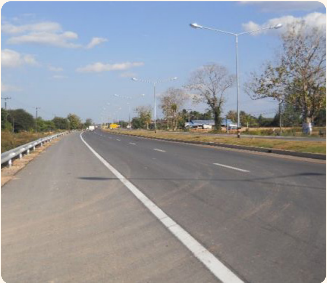
ทางหลวงแผ่นดินหมายเลข 212 ช่วง อ.โพนพิสัย – บึงกาฬ ตอน 1 (4 ช่องจราจร) (เวตฯ นครพนม)
