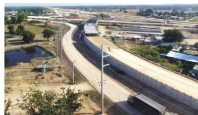
การก่อสร้างทางหลวงพิเศษหมายเลข 81 สายบางใหญ่ - กาญจนบุรี (มอเตอร์เวย์)
