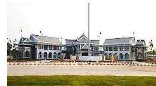
ก่อสร้างด้านศุลกากรหนองคายแห่งใหม่ และลานจอดตรวจสินค้าแห่งใหม่ เพิ่มเติม
