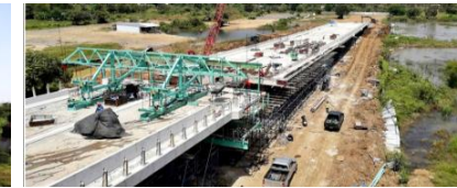
ทล.อรัญประเทศ-หนองเอี่ยน+สะพานข้าม
