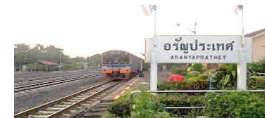
ทางรถไฟแก่งคอย-อรัญประเทศ
