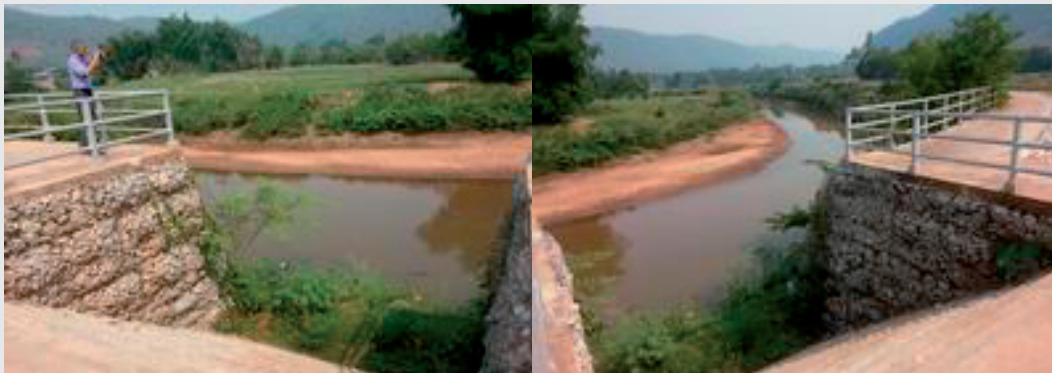
บริเวณที่คาดว่าจะสร้างสะพานข้ามแม่น้ำเหือง บ้านนาข้า ต.ปากหมัน
