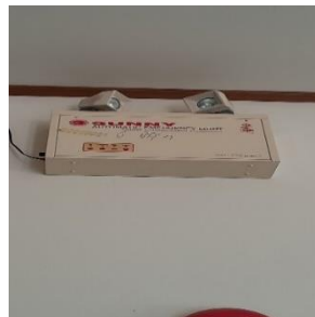
หมายเลข 6 อาคารหอประชุม ฯ โถงบันไดขึ้น-ลง ชั้น 2
