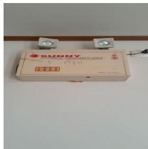
หมายเลข 5 อาคารหอประชุม ฯ โถงทางเข้าชั้น 1 หน้าห้องน้ำชาย-หญิง
