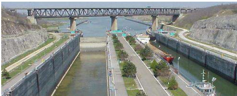
รูปที่ 2.4-21 ปากประตูระบายน้ำคลองดานูบ-ทะเล (Danube – Black Sea Canal) ที่เมือง Cernavoda
