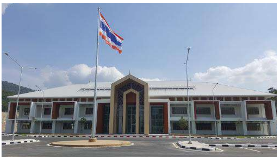
รูปที่ 3.4-12 จุดผ่านแดนถาวรบ้านพุน้ำร้อนที่ดำเนินการก่อสร้างแล้วเสร็จ
