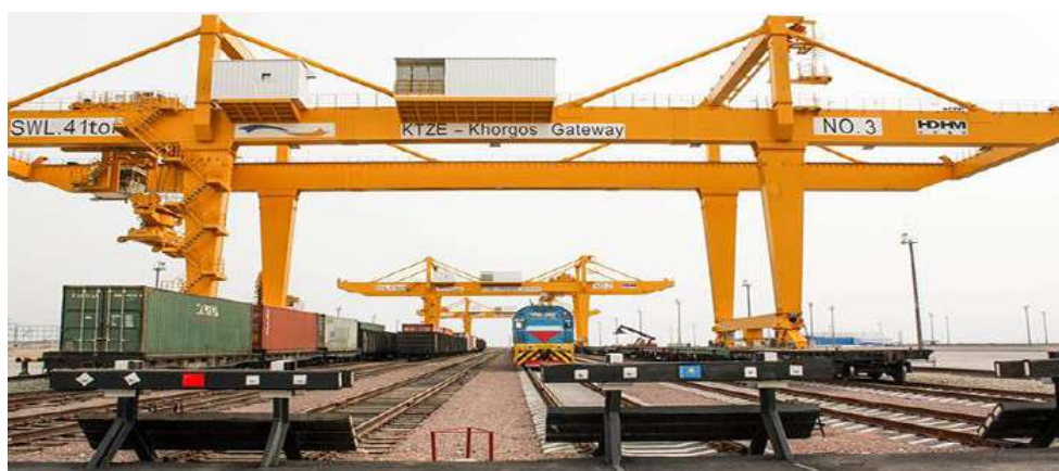
รูปที่ 2.4-6 ศูนย์เปลี่ยนถ่ายสินค้า ณ คาซัคสถาน ที่จำเป็นต้องสร้างขึ้นเพื่อขนถ่ายสินค้าระหว่างรถไฟแต่ละขบวน
