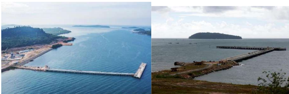
รูปที่ 5.2-61 การก่อสร้างท่าเรือน้ำลึกแห่งที่ 1 ในโครงการ Dara Sakor
