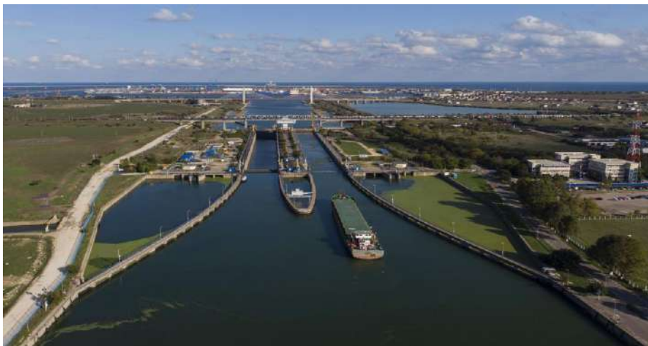
รูปที่ 2.4-20 ปากประตูระบายน้ำคลองดานูบ-ทะเล (Danube – Black Sea Canal) ที่เมือง Constanta
