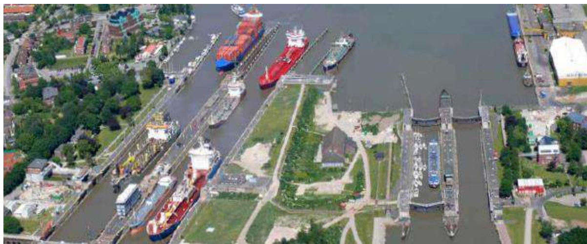
รูปที่ 2.4-18 ประตุน้ำ Burnsbottle ทางเข้าคลองคิล ซึ่งเป็นจุดที่เรือต้องจอดดำเนินการนำเรือผ่านคลอง
