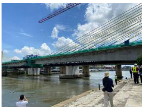
รูปที่ 6 สะพานรถไฟข้ามแม่น้ำแม่กลอง ที่ก่อสร้างในรูปแบบสะพานชิง (Extradosed Bridge)
