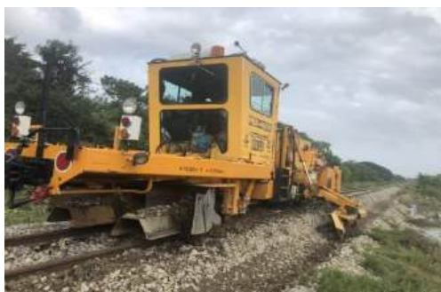
รถบำรุงทาง (รถเกลี่ยหินและรถอัดหิน)
