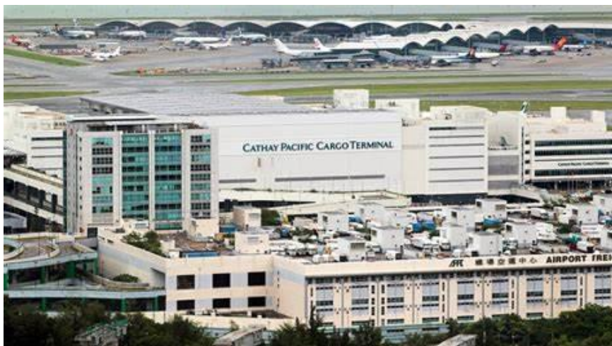
รูปที่ 3.3-16 คลังสินค้า Cathay Pacific Cargo Terminal
